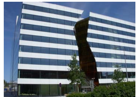
Gli uffici "Ericsson Kista". Ha vinto il prestigioso titolo di "Stockholmsbyggnad 2010" Photo: Holger Ellgaard
